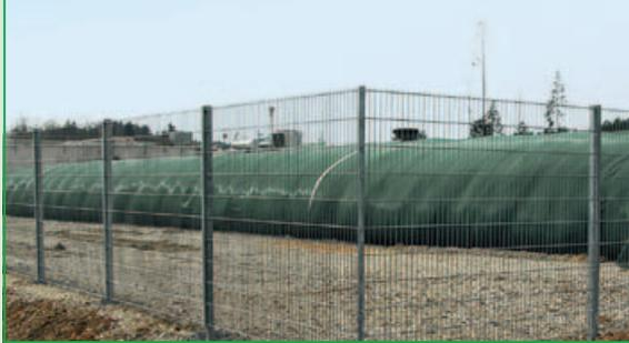
Рисунок: Предохранительная сетка для защиты полимерных рукавов от механического повреждения
